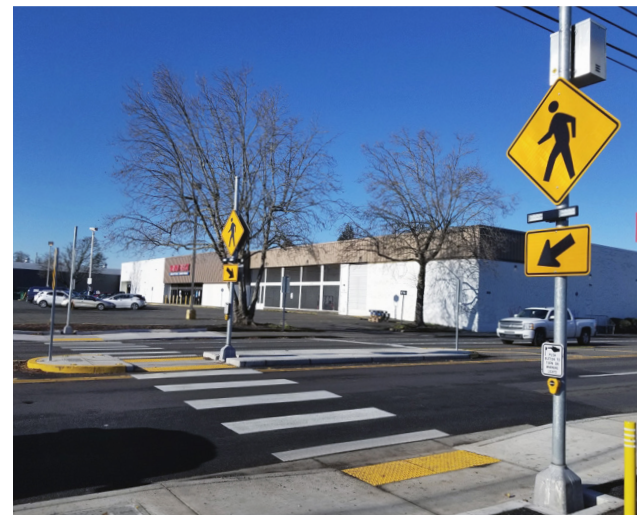
Ejemplo de un cruce con faros rectangulares de parpadeo rápido (RRFB) completado, lo que crea un cruce peatonal más seguro y visible a lo largo de un corredor muy concurrido.
